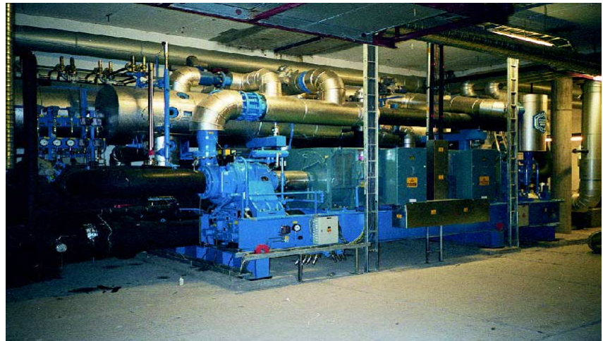
Abb. 3: Typische zweistufige Kälteanlage mit Wärmerückgewinnung
